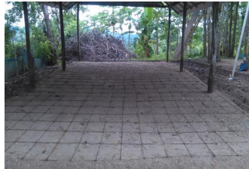
Fotografía 11 APROÑAMM. Núcleo de Bio-insumos vereda Ojo de Agua
