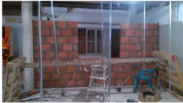
Fotografía 9 APROÑAMM. Rehabilitación oficina, centro de acopio y bodega.
