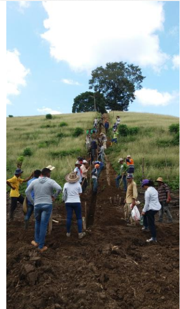
Fotografía 1 Instalación Tubería principal del sistema de riego parcela demostrativa de AMOR A MI TIERRA.
