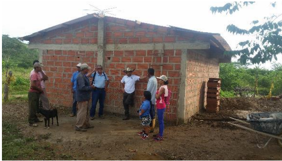
Fotografía 2 ASOBONITO. Oficina y Bodega de Herramientas
