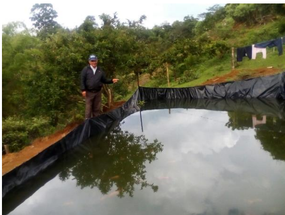
Fotografía 12 APRAT Reservorios Construidos.
