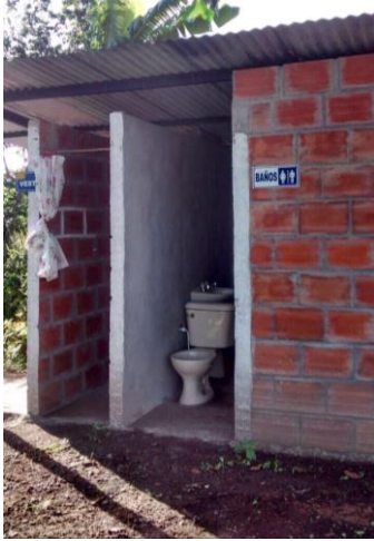
Fotografía 24 ASOFRUTOS, Infraestructura Individual
