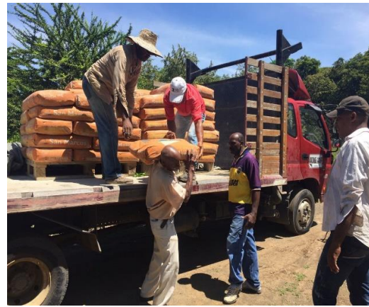
Fotografía 17 ASOBRIX Proceso de construcción de infraestructura
