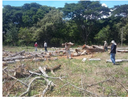
Fotografía 15 ASOBRIX Proceso de construcción de infraestructura
