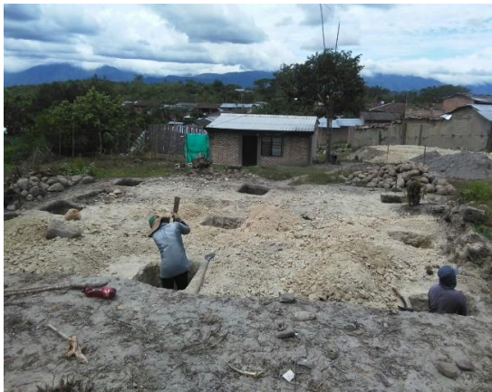
Fotografía 16 ASOAGRAR Proceso de construcción infraestructura
