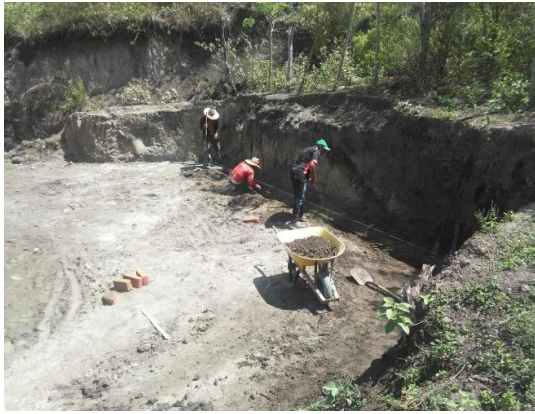
Fotografía 14 ASOMERCADERES Proceso de construcción sala de reuniones
