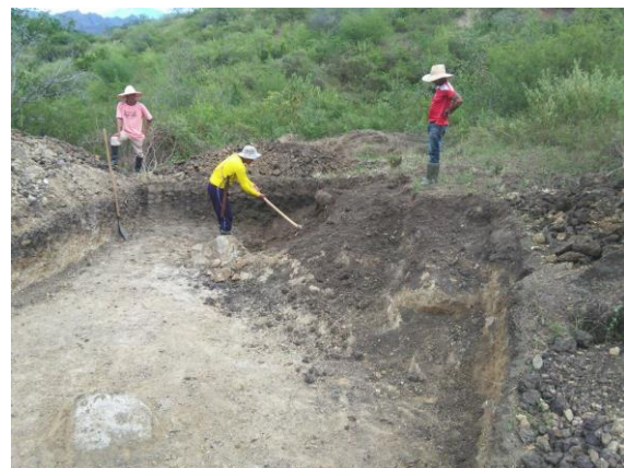
Fotografía 13 ASOAGRAR Construcción de reservorios.
